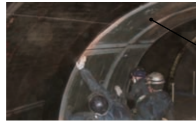
FRP製セグメントを組み合わせる
