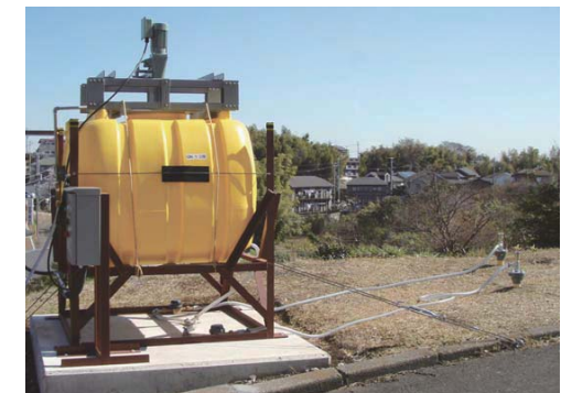
施工例…ここでは重力によって自然流下でデハロアクティブを注入しています。
