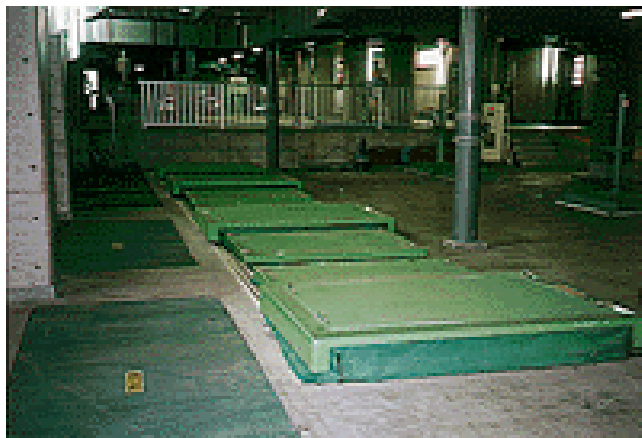
鋼管補強型覆蓋（濃縮槽、曝気槽等用覆蓋）
